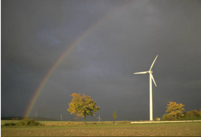
Tacke TW 6003 © Bundesverband WindEnergie
